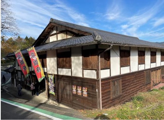
常盤座外観(中津川市指定有形文化財)
