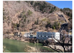
読売発電所：南木曾町
