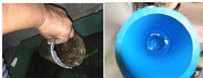
施工前の配管内部
