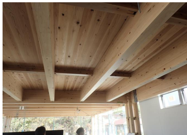
(有)ライン工業新社屋工事中現場を見学
