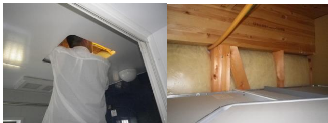
2018、春日井既存住宅現状調査の様子
